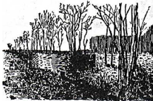
Beim Nähertreten erkennt man, daß sie ringförmig gebaut ist. Es ist die massive Fassung der Hauptquelle des Lorzendorfer Baches. Der Mauerring hat einen äußeren Durchmesser von 4,60 Meter (innen 3,80 Meter) und läßt das Quellwasser durch eine Öffnung nach Süden ausfließen. Beugt man sich über die Mauer, so kann man auf dem schlammigen, über zwei Meter tiefen Grunde das Hervorquellen der Wassermengen beobachten; doch die Oberfläche ist kaum bewegt.
