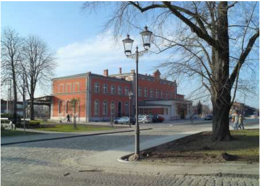
Es wird viel gebaut: der „neue“ Bahnhof
