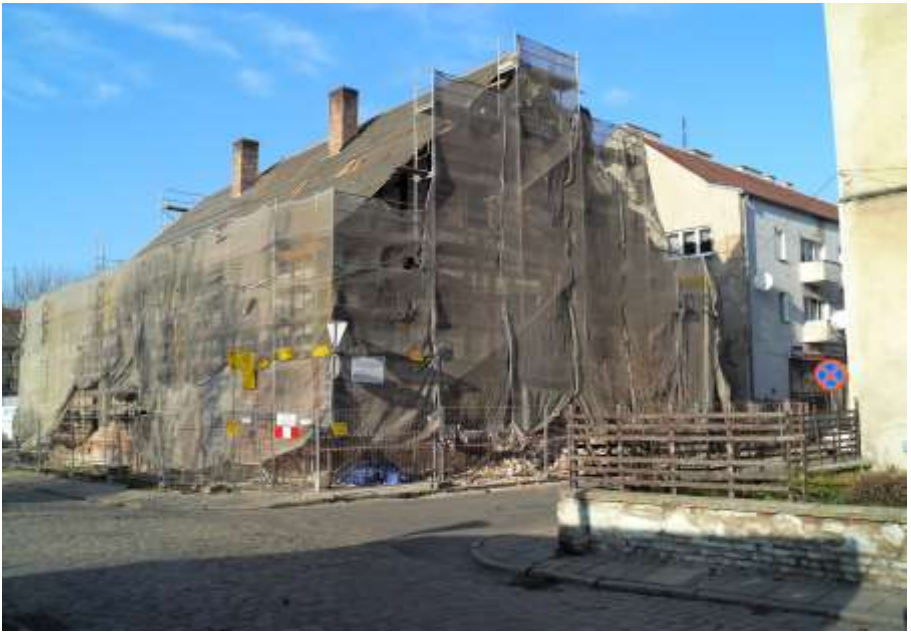
hier entsteht das neue Museum
